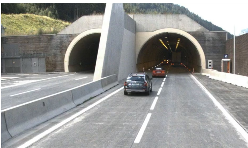
Abbildung 51: RV-Tunnel, Kreisprofil, in Englage mit Trennwand zur Vermeidung eines Lüftungskurzschlusses mit FRS mit sich ändernden Systemsteifigkeiten
