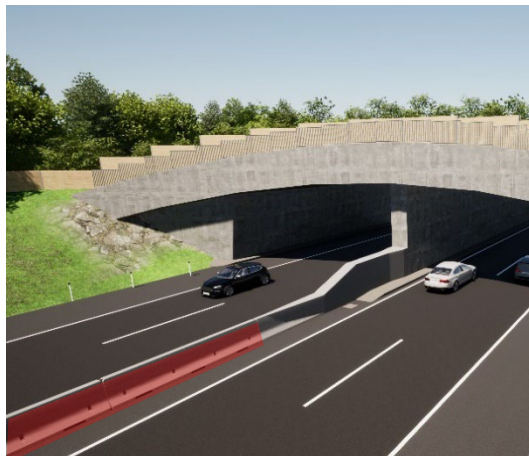
Abbildung 55: Beispiel für Höhen- und Formanpassung (rot markiert die ÜK)
