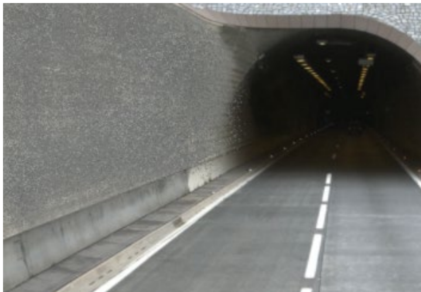
Abbildung 48: Beispiel für eine bündige Anbindung des FRS
