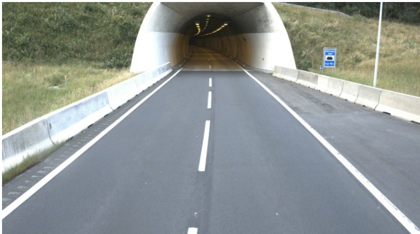
Abbildung 50: RV-Tunnel, Kreisprofil, in Abstandslage, „trompetenförmiges“ Portal mit endverankerten FRS
