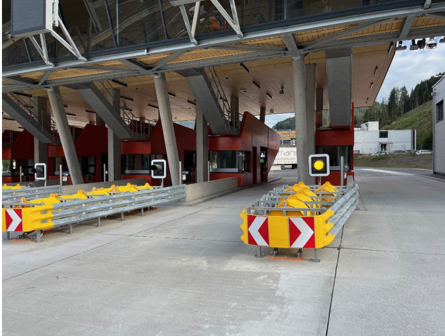
Abbildung 63: Beispiel für die Absicherung einer Mautstation
