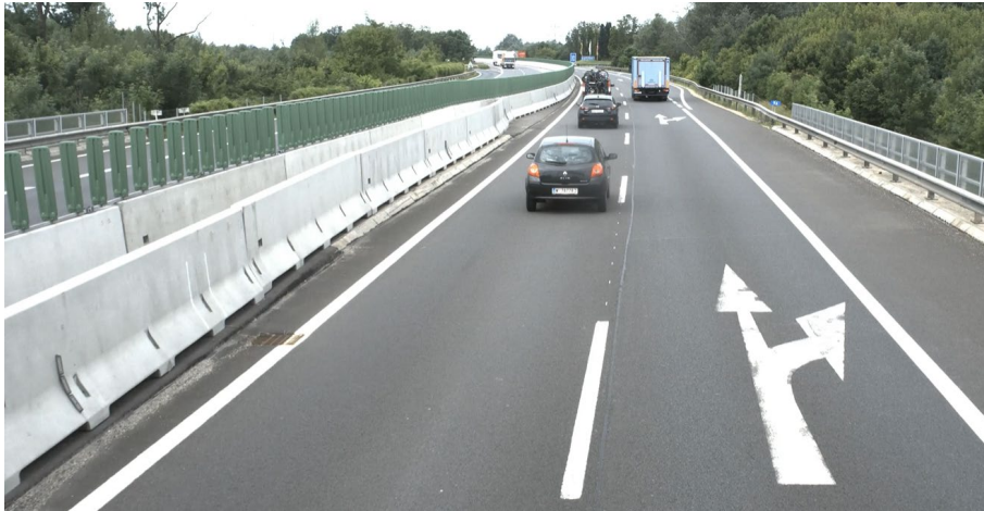
Abbildung 43: Höhenanpassung im Mittelstreifen
