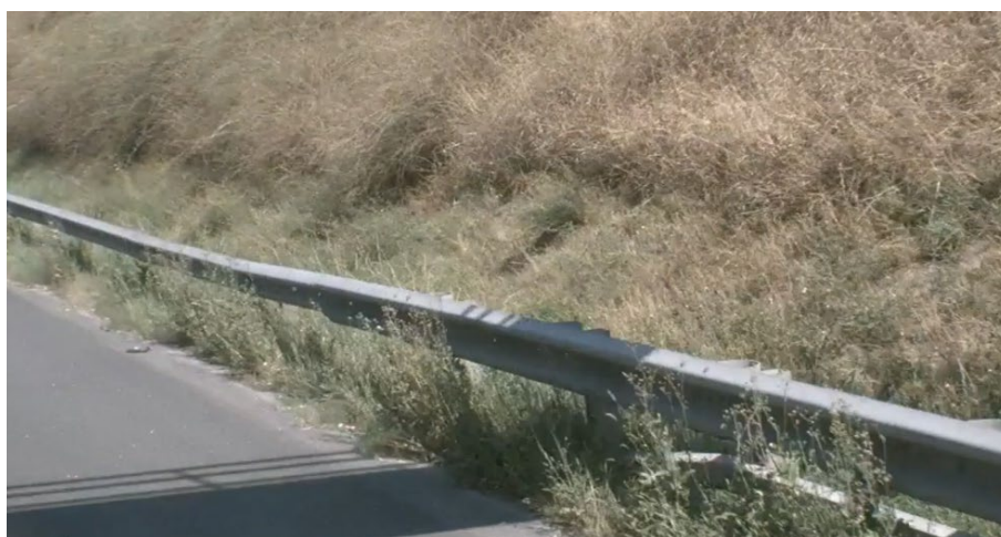
Abbildung 27: Beispiel für eine Verbindung (rechts neues, geprüftes FRS)
