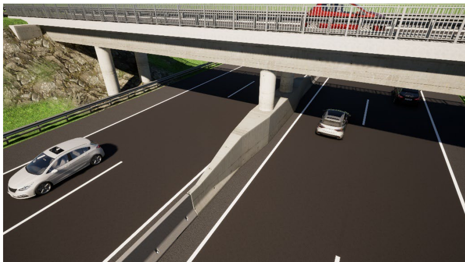
Abbildung 39: Ausführungsbeispiel für das Einbinden eines ortsfesten Hindernisses
