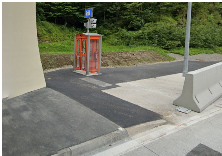
Abbildung 47: Anrampung des erhöhten Seitenstreifens und endverankertes FRS
