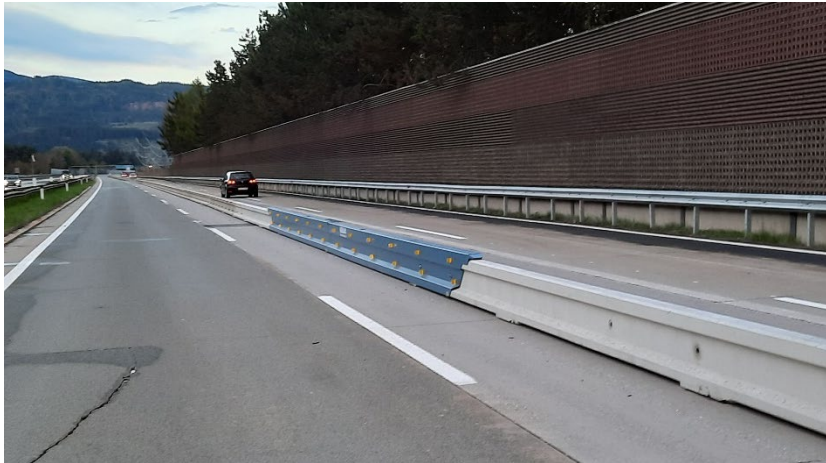
Abbildung 62: Beispiel für ein offenes temporäres FRS
