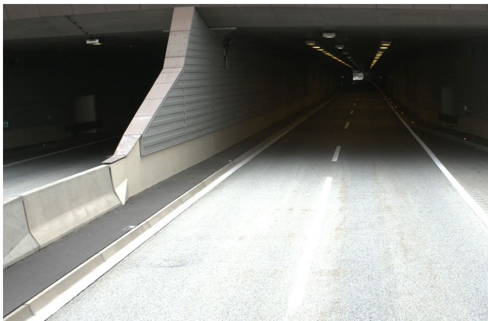
Abbildung 29: Beispiel für einen Anschluss an eine Tunneltrennwand
