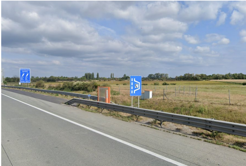
Abbildung 17: Anrampungen bei überlappender Ausführung von FRS
