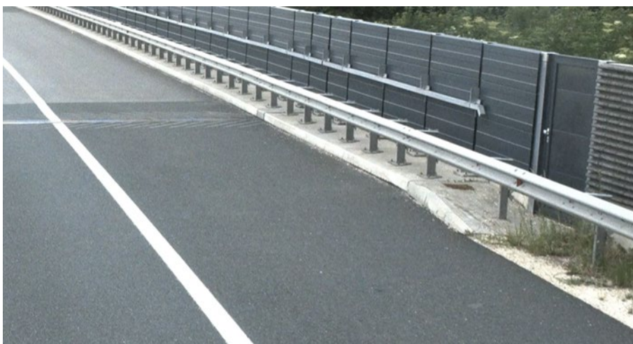
Abbildung 45: Höhenanpassung Bankett - Randbalken
