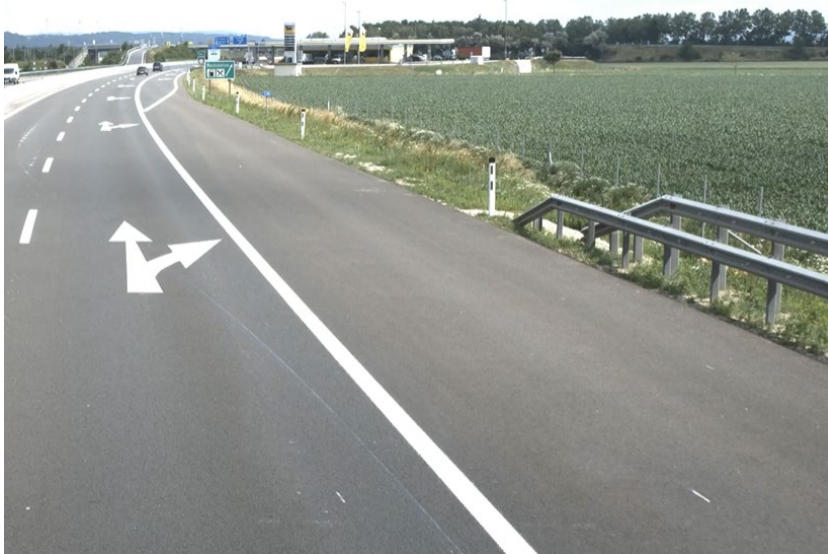
Abbildung 18: Verwendung von Anrampungselementen als Endkonstruktion
