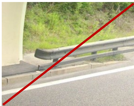
Abbildung 15: Beispiel für eine nicht zulässige „Endschwinge“
