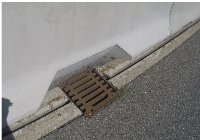
Abbildung 32: Fertigteilelement mit Entwässerungsaussparung
