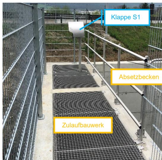
Abbildung 1: Zulaufbauwerk mit Klappe S1
