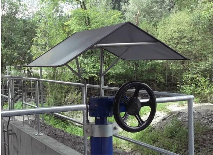
**Abbildung 3: Hochzug Verlängerungsgestänge – Bestätigung Klappe mit Handrad und Schutzdach**
