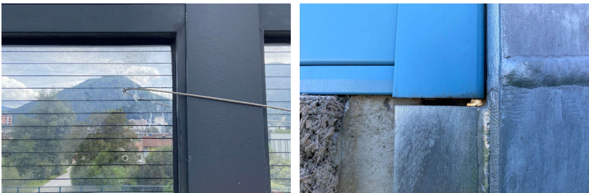
Abbildung 9: Optische Auffälligkeiten der Kategorie 2, da die größte Ausdehnung der Löcher mit Durchsicht unter 10 mm beträgt.
