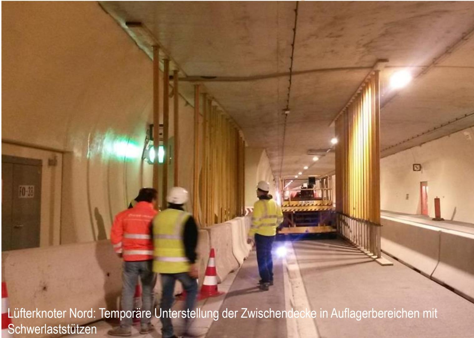
Lüfterknoten Nord: Temporäre Unterstellung der Zwischendecke in Auflagerbereichen mit Schwerlaststützen
